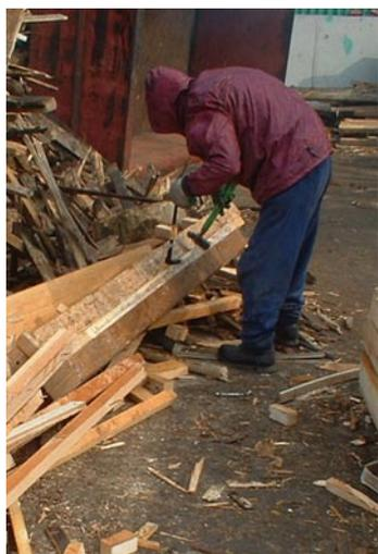
写真1 人手による釘抜き作業
