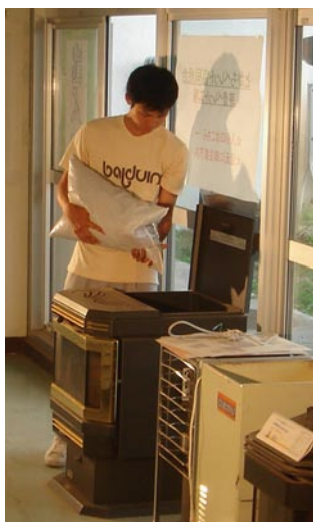
図4 ペレット投入の様子
