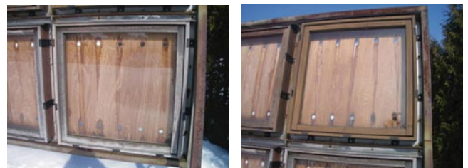
写真2 木製サッシの暴露試験 (浸透タイプ南面 15年目) 左：取付後再塗装無し 右：再塗装有り
