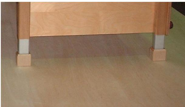
写真 4 アルミパイプと木材の複合による脚
