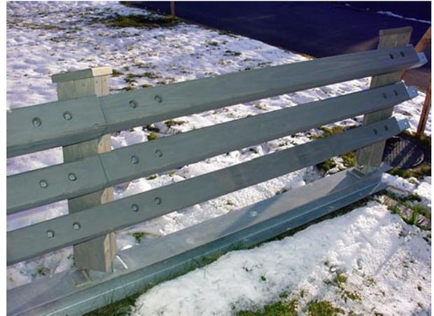
写真1 試作した木製ガードレール（前面）
