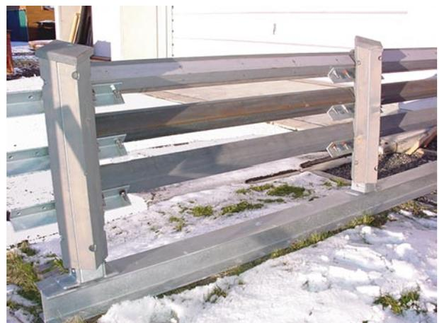
写真2 試作した木製ガードレール（背面）
