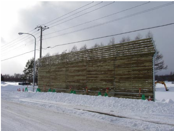
写真2 試験施工した木製防雪柵
