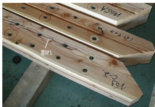
写真1 乾燥により生じた接合部の割れの状況
