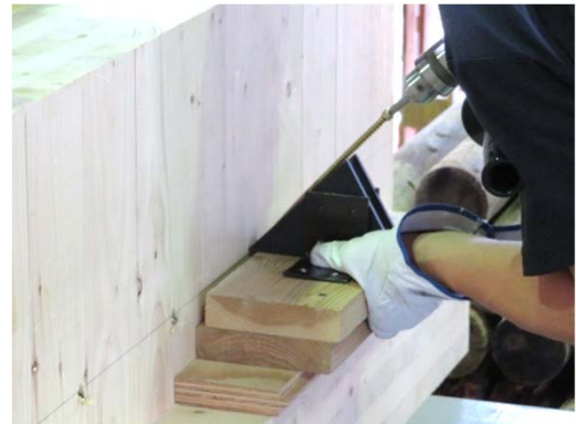
第3図 試験体製作状況
