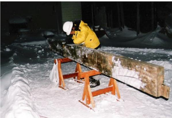
写真1 解体された梁材の形状調査
