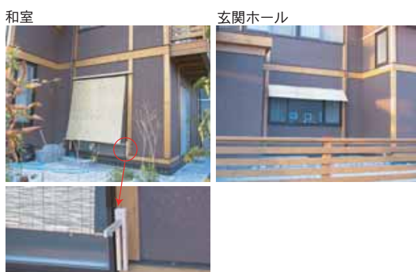
写真6 和室と玄関ホール
