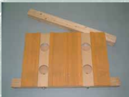
・パネル上部に軒桁を取付ける
