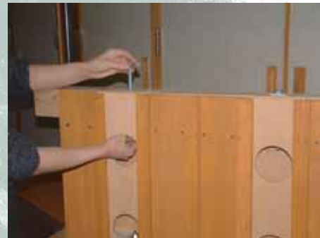
・軒桁とパネルをボルトにて接合する
