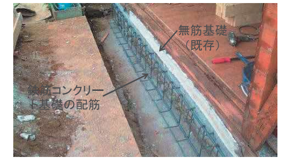
鉄筋コンクリート造基礎を増設
