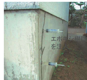
ひび割れの補修
