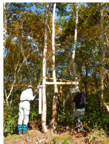
図-3 実際に設置した様子
