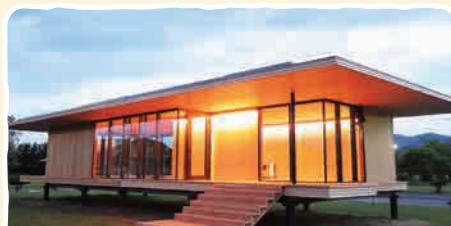
道産CLT(直交集成板)の性能を評価し、 新たな活用を提案する実験棟を建設。
