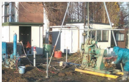
評価用地中熱交換器設置の様子。
