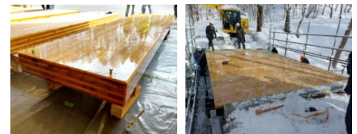
写真4 林道橋改修に用いられたCLT（左）と施工の様子（右）
