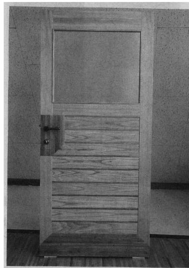
写真4 框組のオフィス用ドア (完成作品)
