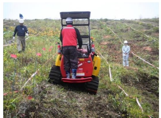
図-6 横傾斜での下刈り作業の様子（京極町）
