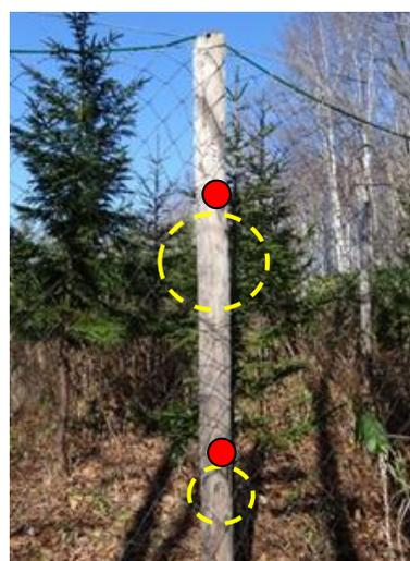
写真-1 ネット固定部の破網の様子
