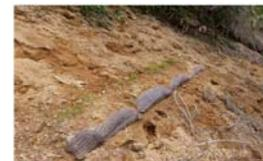
写真-1 表土安定工の施工状況
