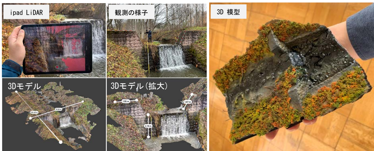
図-4 iPad LiDAR測量の様子(上)と構築した3Dモデル(下)。
