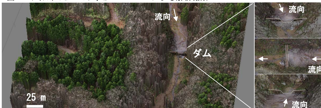
図-2. RTK-UAV空撮画像から作成した治山ダム周辺の3Dモデル
