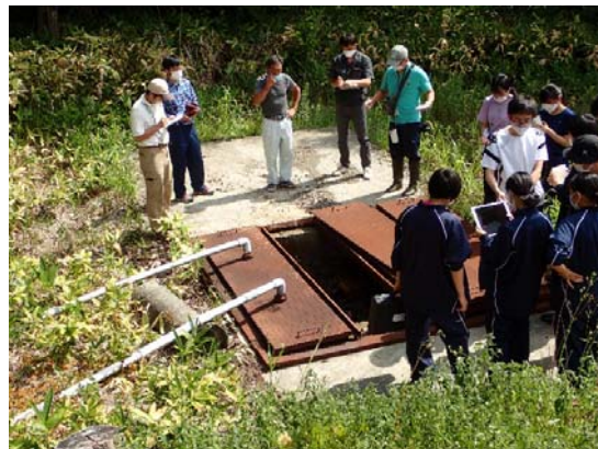
写真-2 簡易処理施設の一例。 写真1の下流地点に設置されている石濾過装置。
