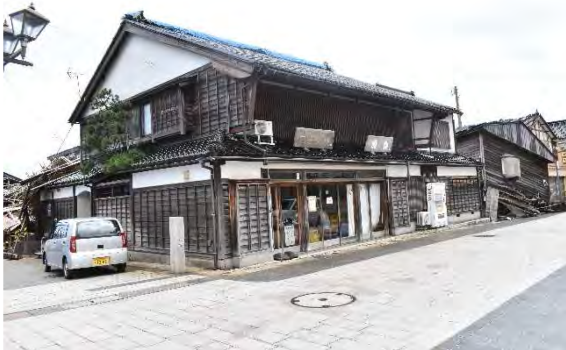
築150年 内部を耐震補強
