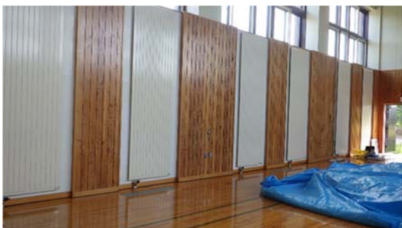
第8図 施設Cの壁面の暖房放熱器（白色のパネル）
