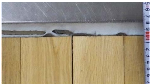
第25図 壁面との隙間（施設A 2021年1月）およびコーキングの亀裂（施設B 2023年2月）
