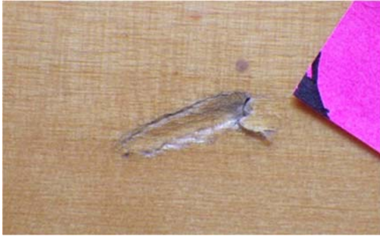
第3図 端部が割れた落下痕（施設C）
