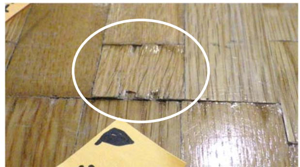
第18図 短辺端部付近で縦継ぎされた短いピースの剥離（施設D 2022年7月）
