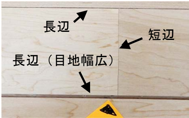
第21図 左：目地幅の広い長辺目地の段差（施設A 2021年1月），右：下に凸の反りによる角部の段差（施設A 2022年2月）
