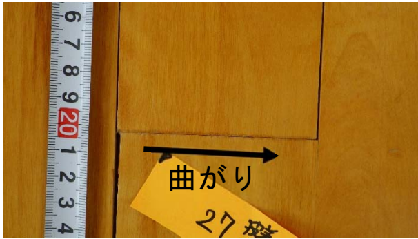
第24図 フローリングの曲がりによる段差（施設C左右同一箇所、左2022年2月、右2022年9月）
