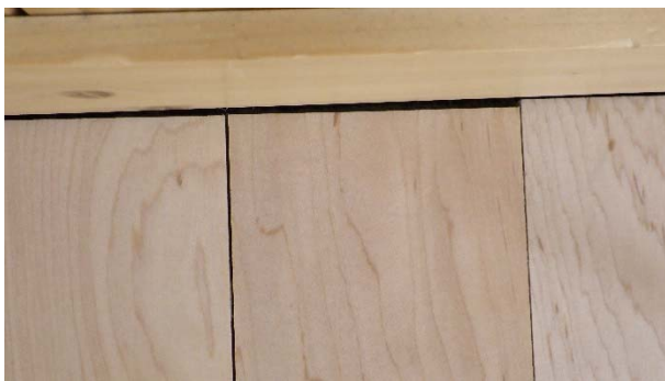
第25図 壁面との隙間（施設A 2021年1月）およびコーキングの亀裂（施設B 2023年2月）
