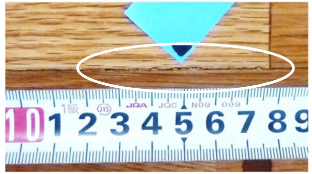
第19図 長辺接合部の目地の固着による割れと目地に沿った細かい割れ（施設D 左：2023年3月，右：2022年7月）
