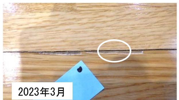
第20図 長辺接合部の欠けの増加（施設D 白丸：2022年7月に欠けを確認した部分）
