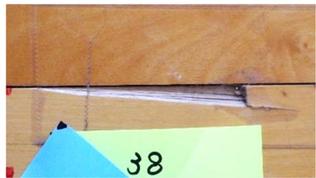
第16図 割れと複合的に発生した欠け （施設C 2022年2月）
