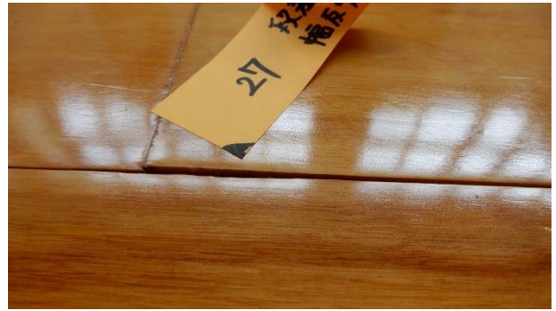
第24図 フローリングの曲がりによる段差（施設C 左右同一箇所、左2022年2月、右2022年9月）
