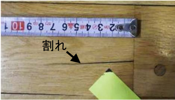
第9図 短辺接合部の割れ（左：施設B 2022年1月，右：施設A 2022年8月）
