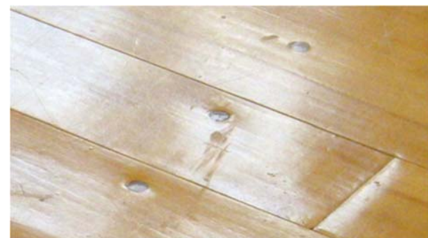
第12図 ビス留め位置でのフローリングの膨潤の抑制の一例（施設C 2024年7月）
