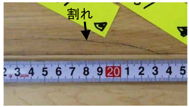
第7図 接合部の圧縮による割れ 左：繊維に沿った割れ（施設A 2021年2月），右：繊維を横切る割れ（施設A 2021年8月）
