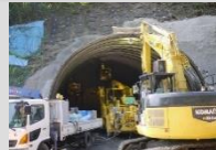
トンネル掘削 土壌汚染対策
