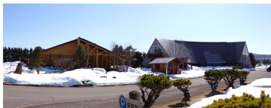
林産試験場の展示施設外観
