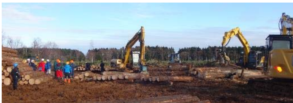
写真 4 ICT ハーベスタによるトドマツ造材と山土場選木の現地検討会 (2024 年 11 月 枝幸町)
