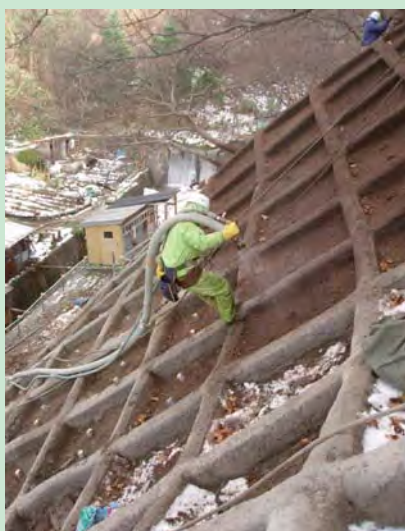
写真-1 吹付け施工の様子
