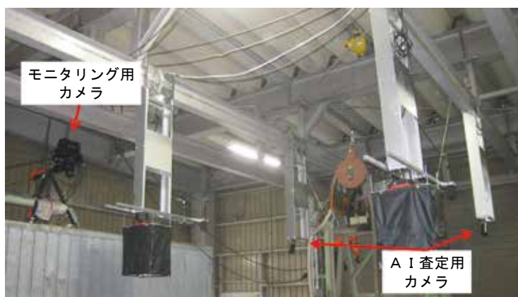
受渡査定現場に設置したモニタリング用カメラと AI査定用カメラ
