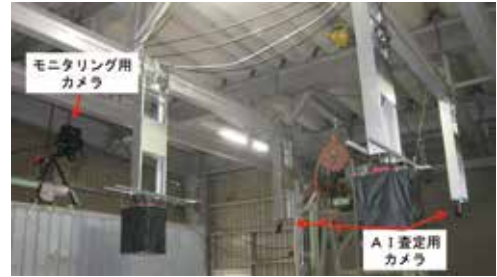
受渡査定現場に設置したモニタリング用カメラとAI査定用カメラ
