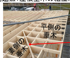
屋根垂木の施工状況
