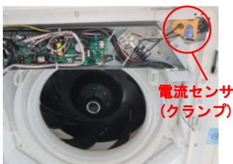
写真1 室内機の電流測定
