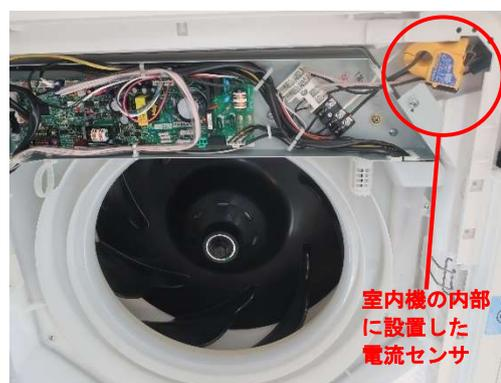
写真 1 室内機の電流測定の様子
