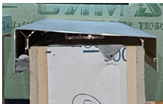
写真 3.2 パラペット頂部の断面
