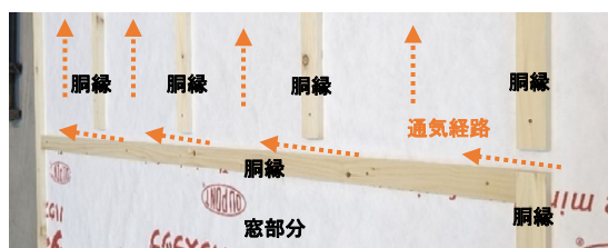
写真 4.1 窓周囲の通気経路
