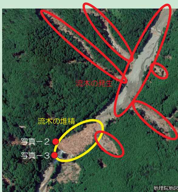
写真-1 ダム付近の流木発生・堆積箇所 背景には国土地理院撮影の空中写真 (2017年7月13日撮影)を使用 写真-2と3の撮影位置も併せて示す
