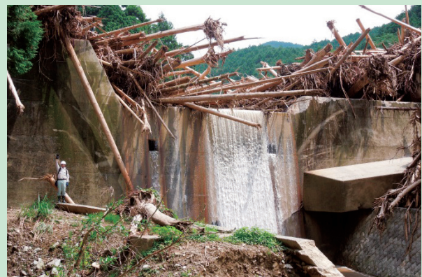
写真-3 流木の流下を阻むダム
