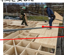
屋根合板の施工状況
