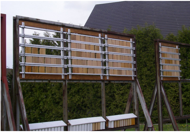
写真2 暴露開始時の試験体の状態 (旭川)
