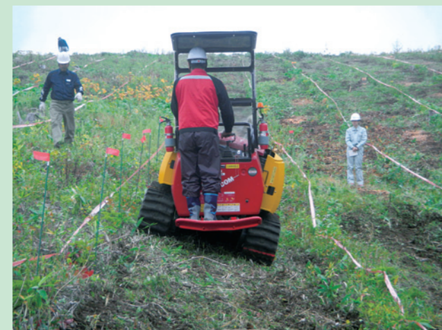
写真-2 横傾斜でも作業可能(2018年10月)
