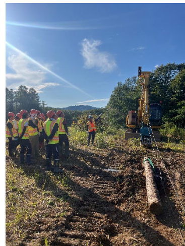
【スイングヤーダによる集材作業】
