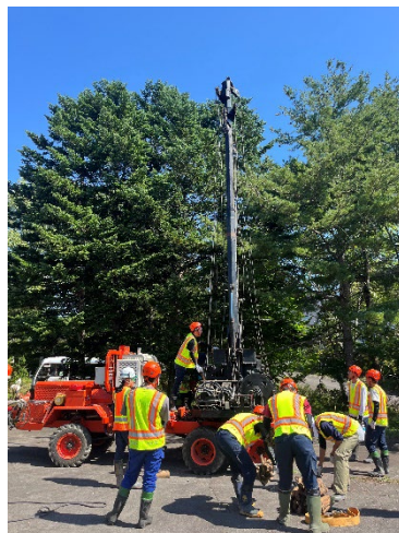
【タワーヤーダの索張り】
