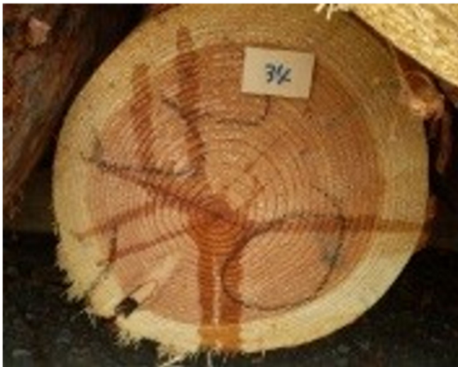
写真1 カラマツの心割れ
