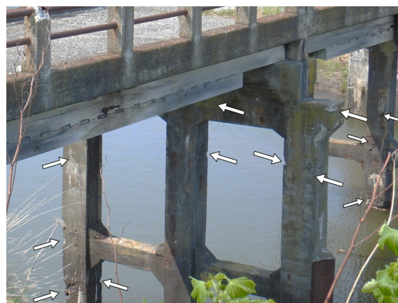
図6 コンクリート橋脚・高欄の様子
