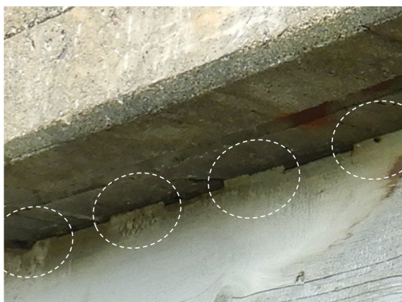
図4 木桁と床版下面のかみ合わせ
