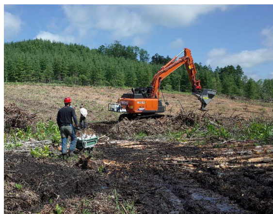
写真7 P12.a と小型運搬機の連携
