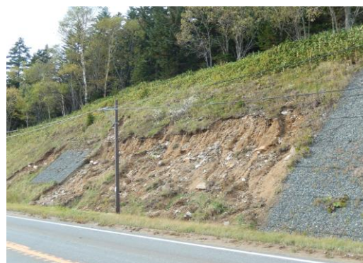
図36. 湧水による法面崩壊
