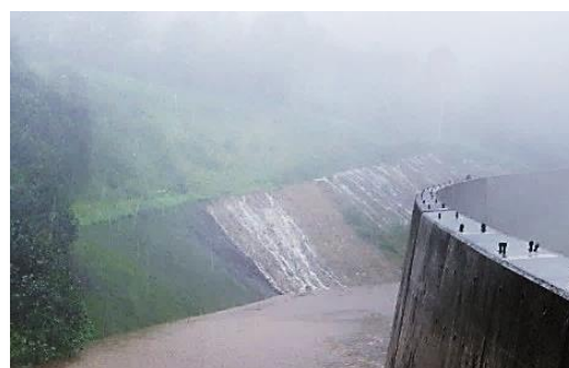
図35. 排水施設からのオーバーフローによる法面の侵食
