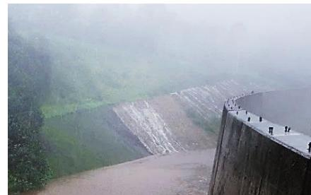
図資料 5-7 排水施設からのオーバーフローによる法面の侵食
