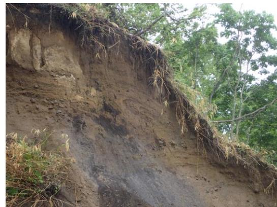
図 4.2-7 崩壊土砂の主体となった周氷河堆積物
