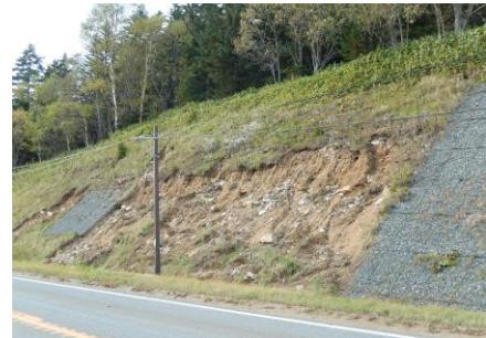
図資料 5-8 湧水による法面崩壊
