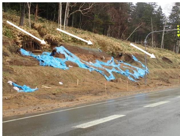
図 4.3-1 ガリータイプ斜面崩壊の下方に位置する切土法面に生じた崩壊・侵食
