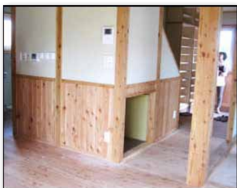
実証住宅の様子
