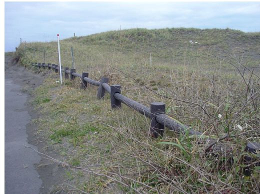
写真2 車両侵入防止柵（石狩海岸）。
