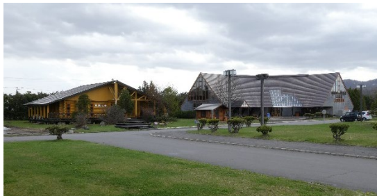
【林産試験場の展示施設外観】
