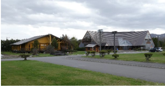
【林産試験場の展示施設外観】
