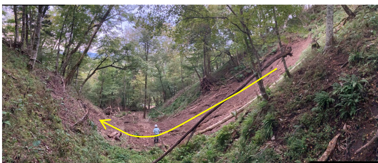
図4 白糠町和天別川島の斜面崩壊(発生域) 崩壊土砂が対面の斜面に乗り上げ(黄色矢印)、その後、写真奥側に流走。
