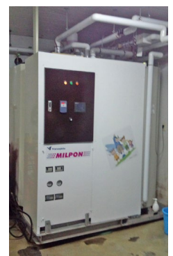
図7 牛乳排熱を利用した ヒートポンプ給湯システム
