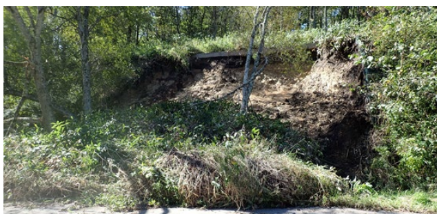
図6 音別町直別原野基線の斜面崩壊 作業道からあふれた水流が直下の法面崩壊を招いた。
