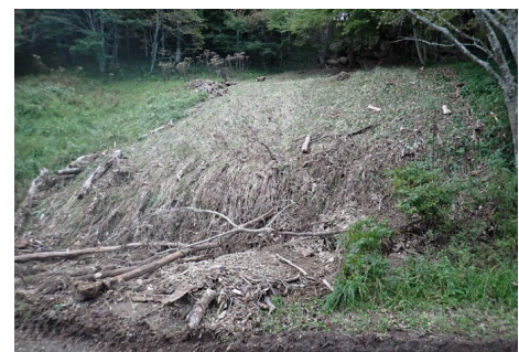
図5 白糠町和天別川島の斜面崩壊(末端) 斜面中腹に土砂を残し、下部で水の割合が増加。
