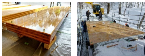
写真1 林道橋改修に用いられたCLT(左)と施工の様子(右)
