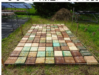
写真5 設置直後の様子
